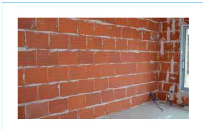
Figure 4 - Contre-cloisons (source : Bio bric)
