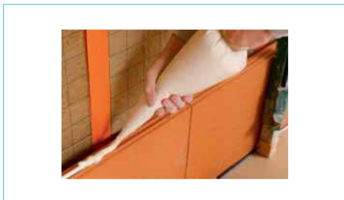
Figure 3 - Montage des contre-cloisons (source : Bio bric)
